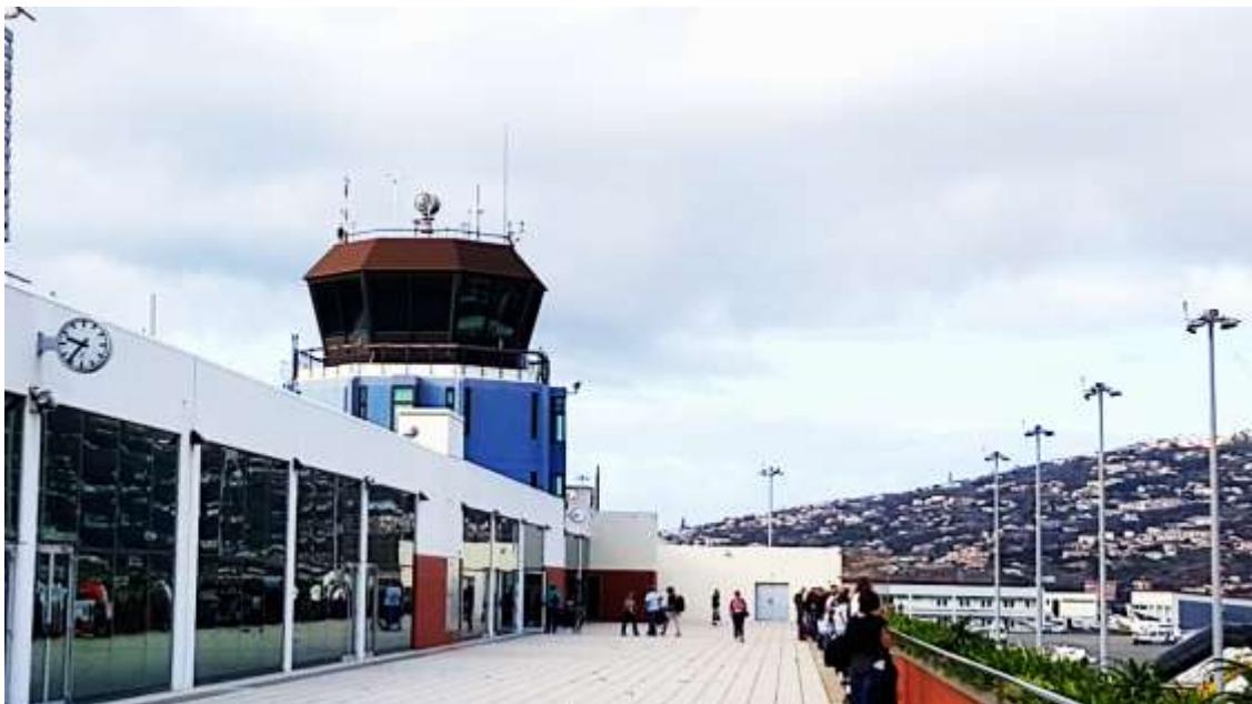
Figura 384. Madeira airport. Portugal.
