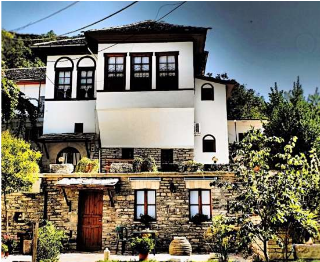
Figura 148. Gjirokastra. BabaMeto Hostel.
