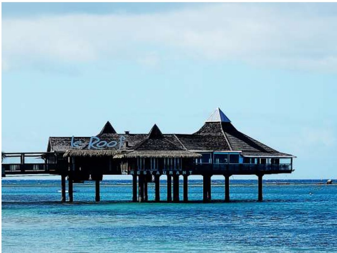
Figura 189. Le Roof, Caledonia e Re
